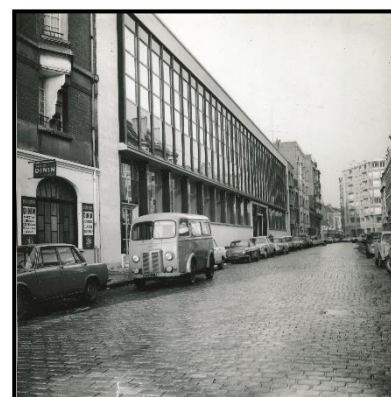
Vue de la Médiathèque Jean Lévy Archives de la bmL
